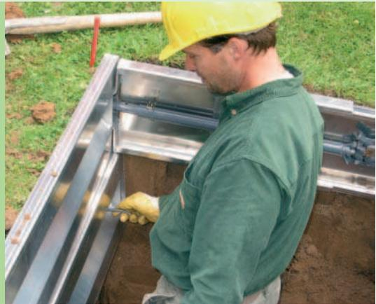
Aus Gründen des Gesundheitsschutzes (Ergonomie und Handhabung) sind vorzugsweise metallene Verbaubohlen, z.B. aus Aluminium, für die Handschachtung einzusetzen. Eine Einheit besteht entsprechend der Grablänge aus den beiden Längsböhlen und den zwei teleskopierbaren Stirnböhlen.
