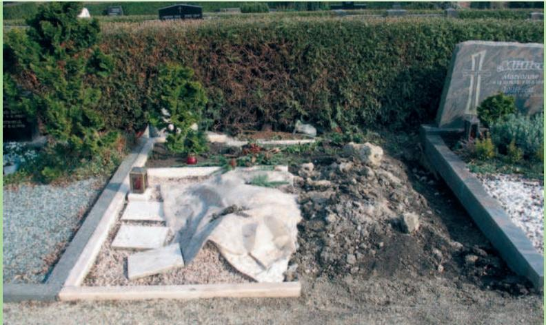
Für den Grabaushub, insbesondere für die erforderlichen Verbaumaßnahmen, ist in aller Regel ein freies Raummaß von 0,90 m Breite x 2,30 m Länge erforderlich.
