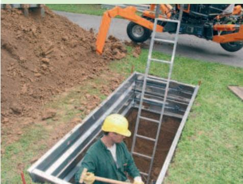
Grabränder dürfen nicht mit dem Erdaushub, Maschinen, Geräten und dergleichen belastet werden. Ein Schutzstreifen von 0,6 m ist freizuhalten. Je nach örtlichen Verhältnissen ist daher der Erdaushub abzufahren oder z.B. in speziellen Erdcontainern, die neben dem Grab aufgebaut werden können, gesondert zu lagern.
